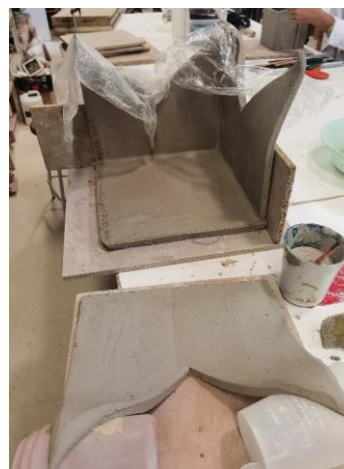
Taller: Construcción de la pieza
